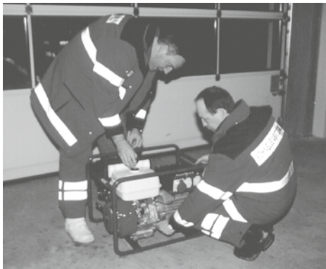
Eines der Notstrom-Aggregat wird überprüft.
